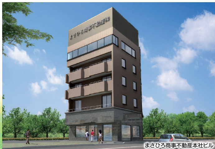
まさひろ商事不動産本社ビル
