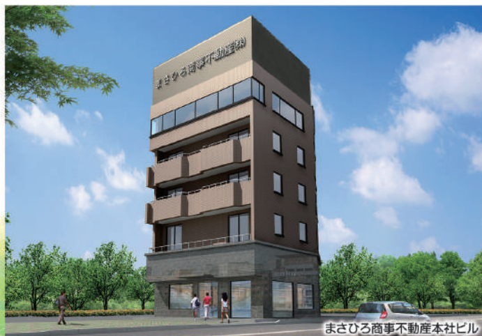
まさひろ商事不動産本社ビル
