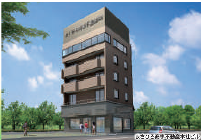
まさひろ商事不動産本社ビル
