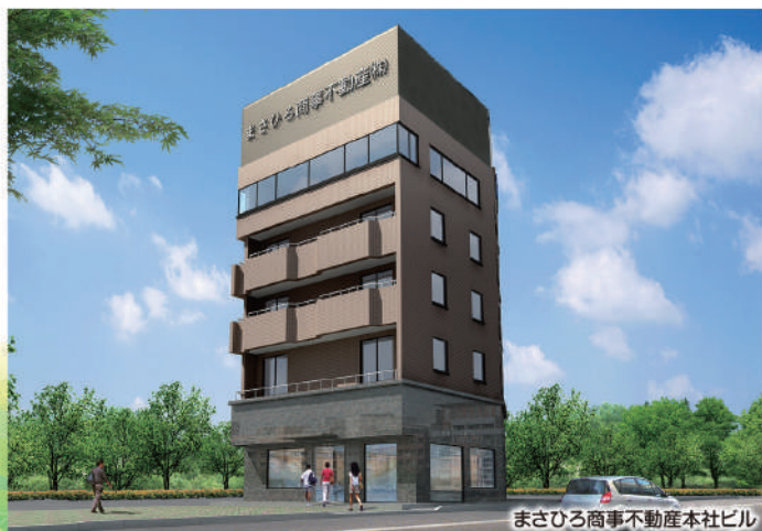
まさひろ商事不動産本社ビル
