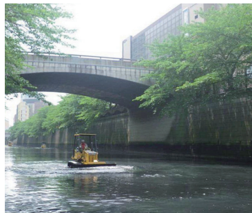
目黒川の川底を均す工事
