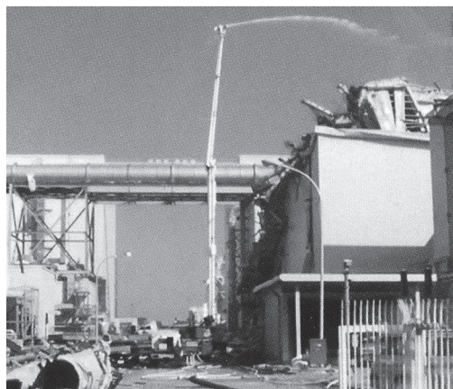
屈折放水塔車による福島原発3号機への注水活動
