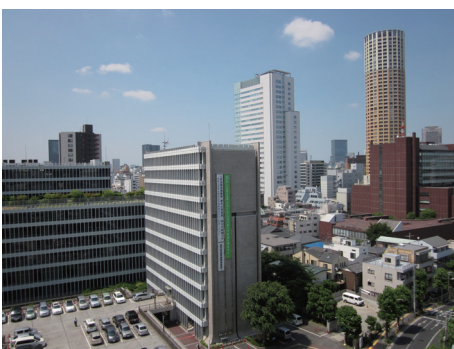
中目黒再開発の高層ビルと目黒区総合庁舎
