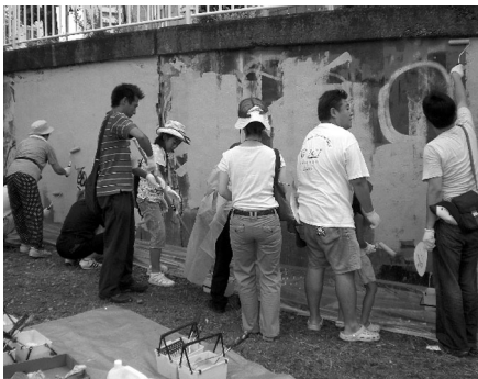
新道坂での作業風景
