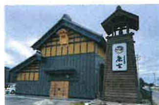
和モダンで統一された本社や倉庫
