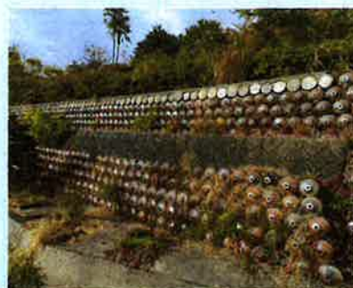
検瓶に不合格だった瓶で作られた三好御瓶垣。硫酸瓶は道路の中央分離帯や民家の軒先、公園などにも置かれている
