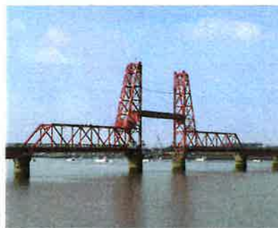
長さ24m、重さ48tの可動橋が5分で23m上昇するさまを間近で見ることができる。橋ウォッチャーならずともその迫力に圧倒！
