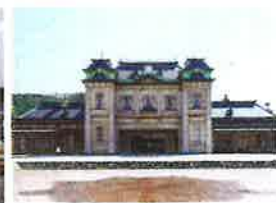
重要文化財の門司駅舎
