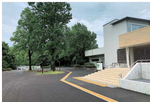
リニューアル化された陸上競技場管理棟
