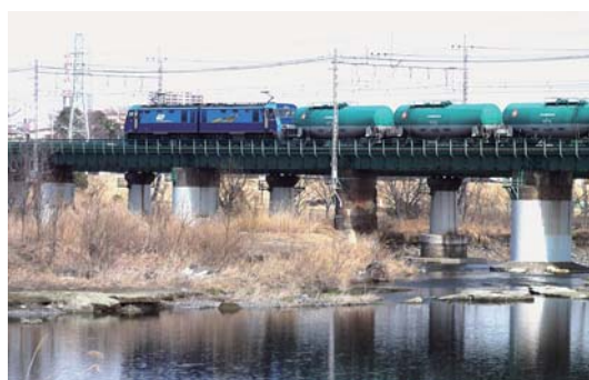
▲現在の多摩川鉄橋 橋脚のほとんどは補修されて白く塗られましたが、赤煉瓦の橋脚が一つだけ残されています。
