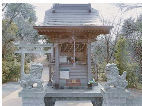
▲平成18年に氏子たちにより修復された
