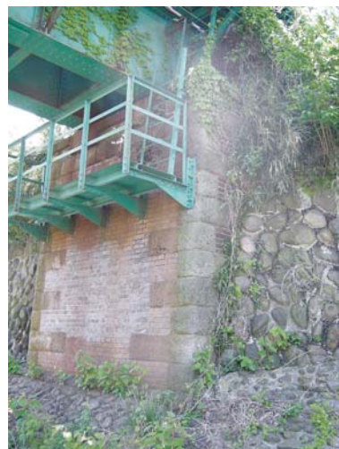
多摩川鉄橋上り線橋脚南詰
