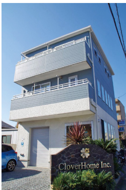
花小金井事務所外観
