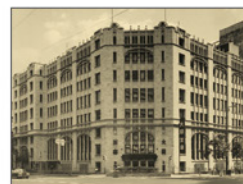
旧肥後橋本社ビル (設計：W・M・ウォーリス)
