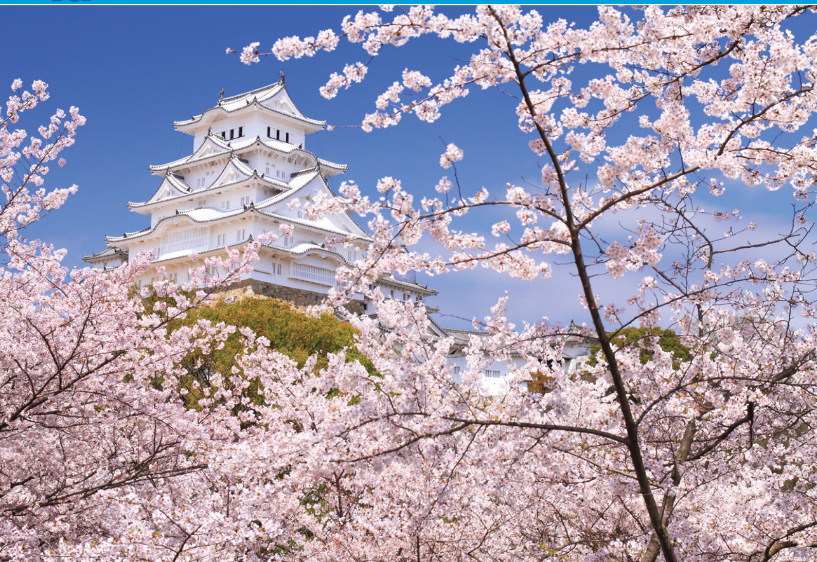
4月兵庫 保存修理工事完了後の姫路城連立式天守群と桜
