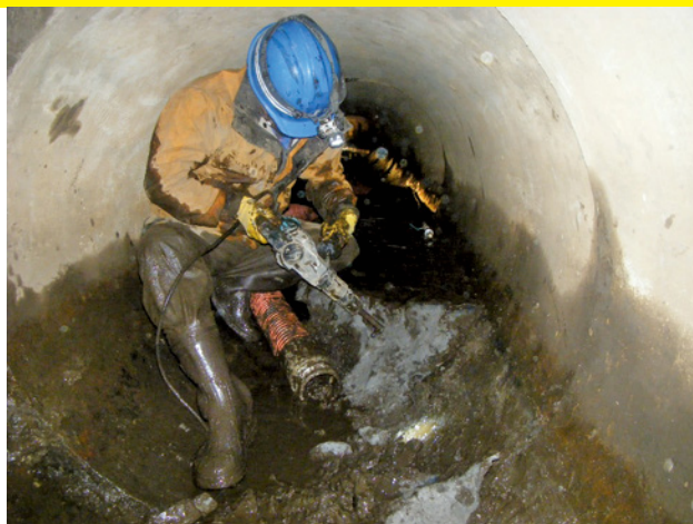
不法に投棄されたコンクリートの除去
