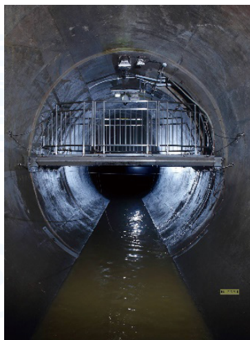
■下水道管内の見学ステージ 撮影 白汚 零氏
