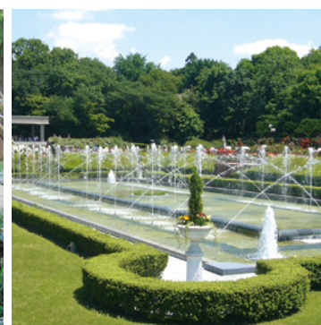
神代植物公園 噴水工事
