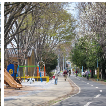
狭山境緑道 園路改修工事
