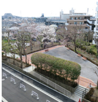
都営中原 アパート外構改善工事
